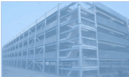
De tijdelijke parkeergarage Balast Nedam is ook permanent in te zetten.
